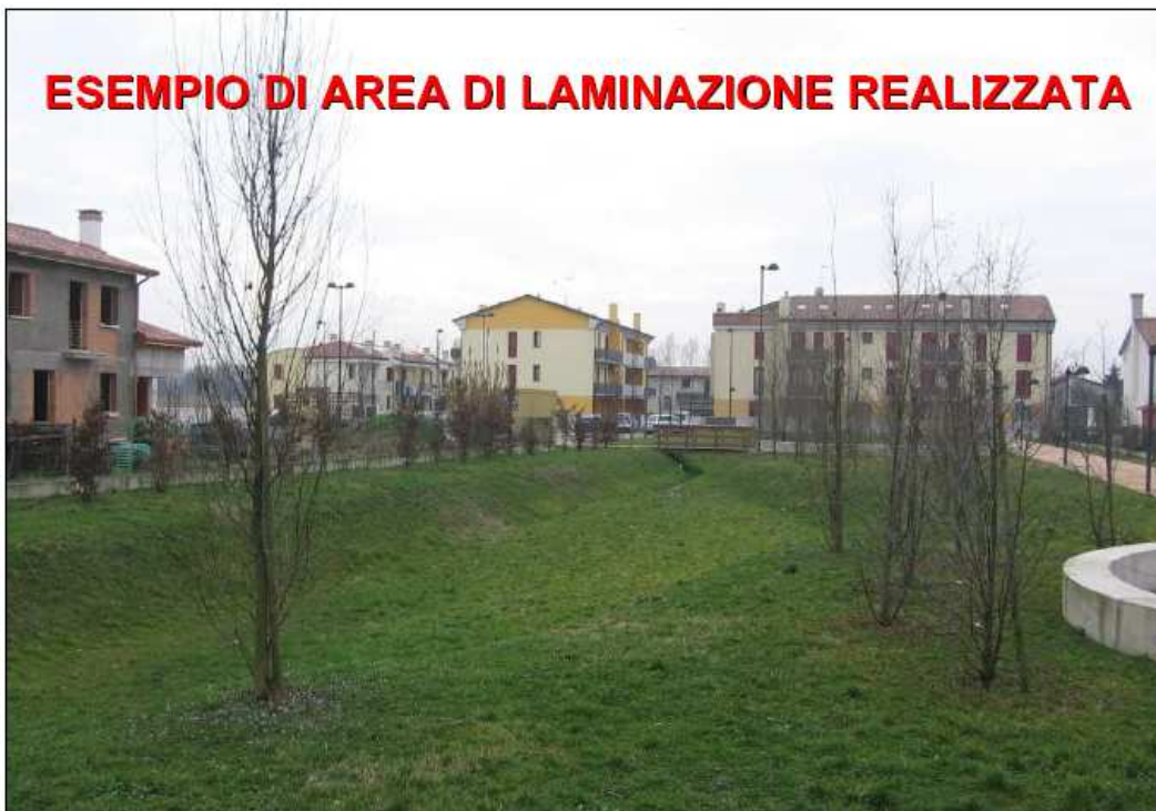
Figura 3 – Esempio di bacino di invaso realizzato (fonte: CdB Acque Risorgive)
